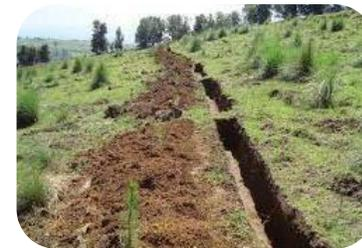
1. Zanjas de infiltración
