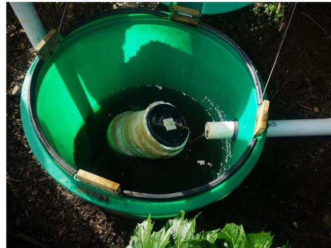
\* Velar que no entren sólidos flotantes a la cámara de pulso que puedan obstruir válvula o sistema de tuberías
