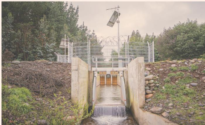
Una de las compuertas modelo Flumegate instalada para la Junta de Vigilancia Rural del Río Ñuble.
