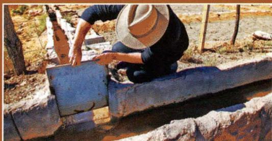
**Figura 5.** Compuerta metálica que permite la distribución del agua de riego al interior del predio.
